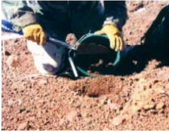
Step 1 Dig Trap Hole
